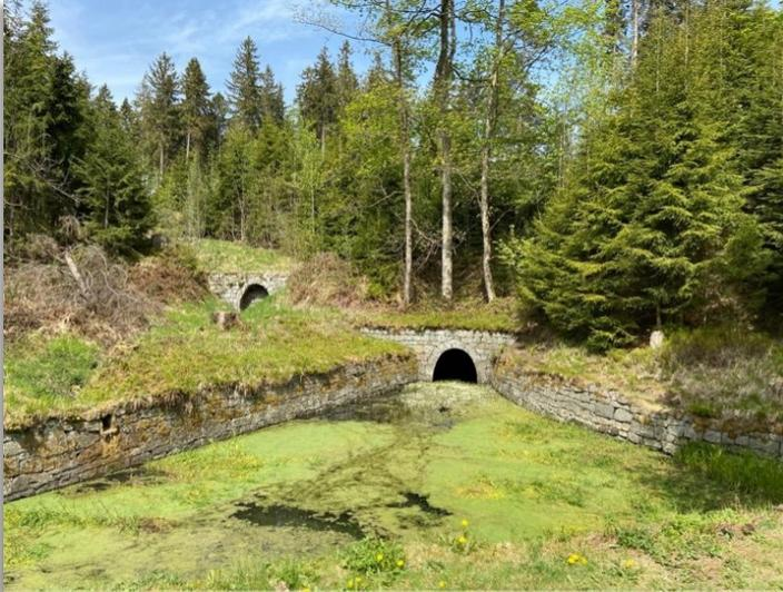
Die Huttaler Widerwaage mit dem Mundloch des Huttaler Wasserlaufs. Links befindet sich ein kleiner Stollen, der vermutlich beim Bau der Widerwaage aufgefahren wurde.
