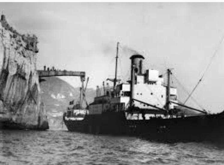
Charging Ship in Porto Flavia Operazioni di Carico a Porto Flavia
